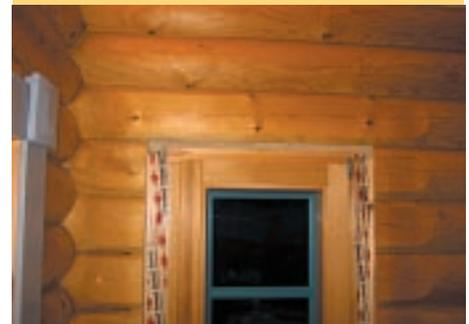
**Bild 7: Beidseitige Verklebung mit dem Fensterdübel.**
