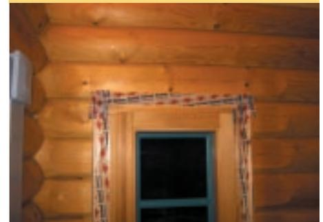
**Bild 8: Abschließende Verklebung des oberen Setzungsraumes.**
