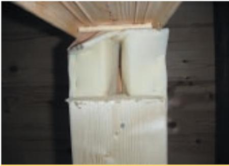
**Bild 3: Eingebauter Fensterdübel mit darüberliegendem Setzungsraum.**
