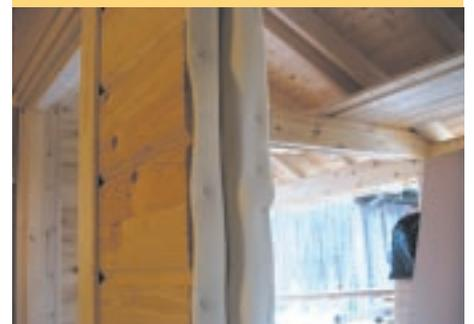
Bild 2: Beidseitig verlegtes Kompriband in der Fensternut.
