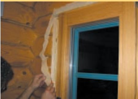
**Bild 4: Bearbeitung der Dämmung zum bündigen und sauberen Abschluß als Voraussetzung für das Verkleben.**
