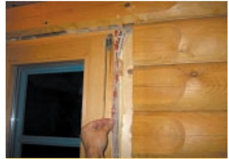
**Bild 6: Anbringen des Klebebandes zwischen Fenster und Fensterdübel.**
