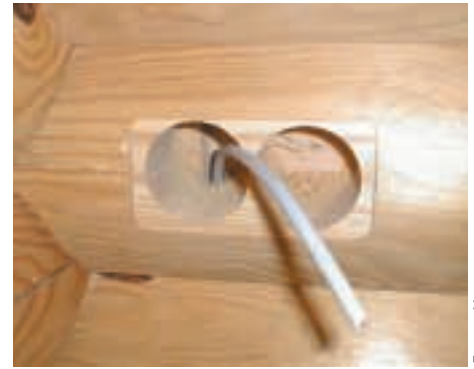
Die Form der Abdeckung ist flach ausgefräst und die Dosen wurden mit einem Forstnerbohrer ausgefräst.
