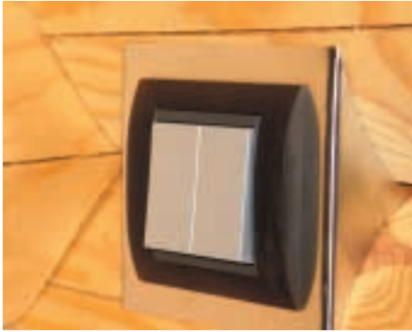
Das Edelstahlblech dient als Montage-rahmen für Steckdosen oder Schalter.
