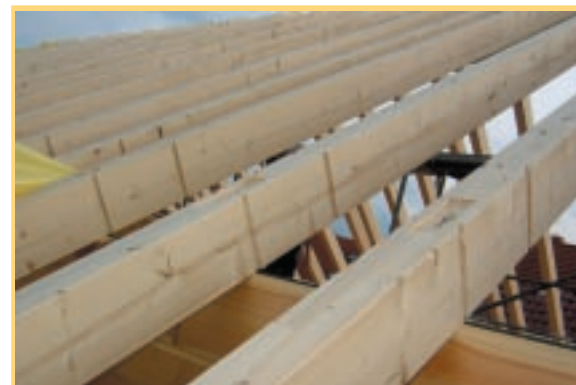
Eingefräste Stellbretter über der Außenwand, innen und außen, sind heute Standard.
