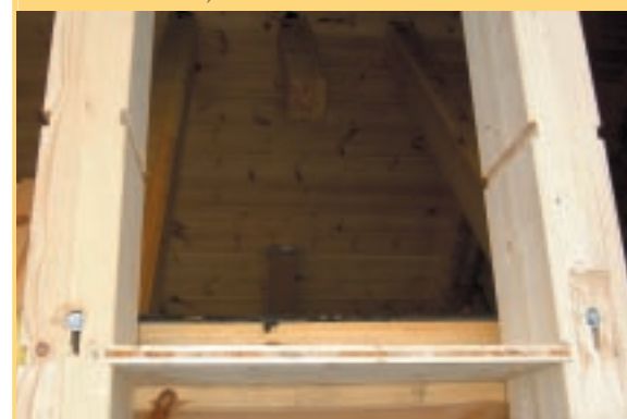
Nach der Montage bzw. vor der Setzung stehen die Stellbretter noch weit vor der Fußfette.
