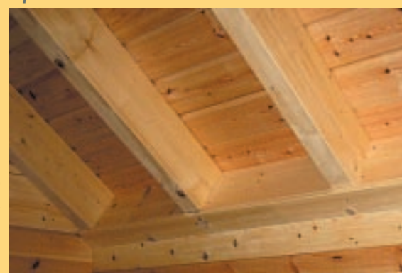
Die detailgenaue Ausführung lässt sich nur durch einen Luftdichtigkeitstest kontrollieren.
