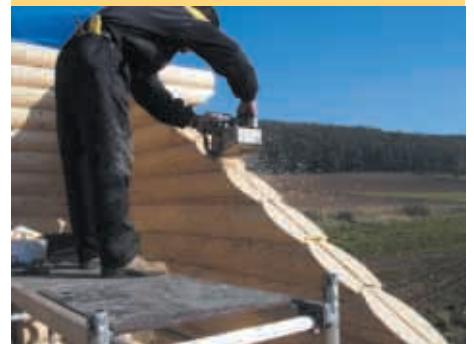
Bild 3: Mit einer Säge wird ein sauberer Schnitt über den Giebelgrat vorbereitet.
