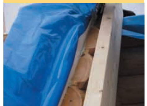
Bild 4: Die Dichtmasse wird präzise in und neben den Schnitt verteilt.
