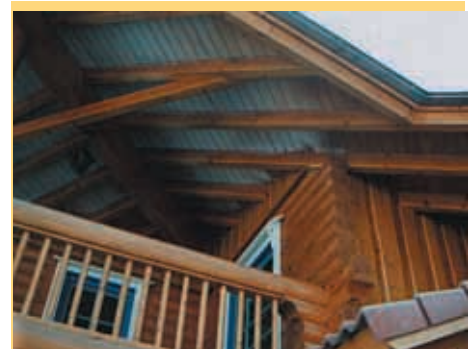
Bild 1: Im 'Condetti'-System ist die dichte Anbindung des Daches aufwändig.
