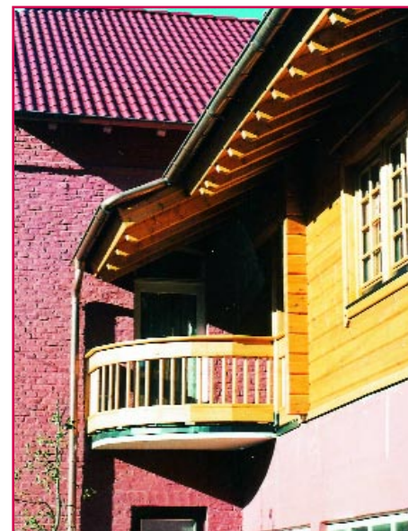
Ein dekorativer Balkon bildet einen optischen Übergang zum alten Ziegelhaus.
