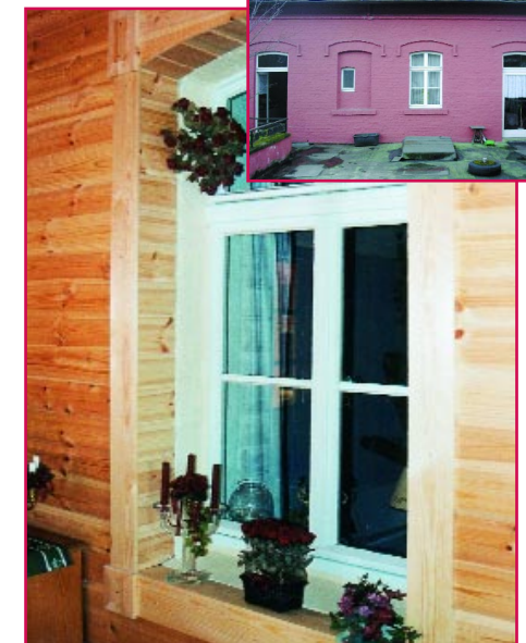
Das alte Außenfenster wurde geschickt in den neuen Anbau integriert.
