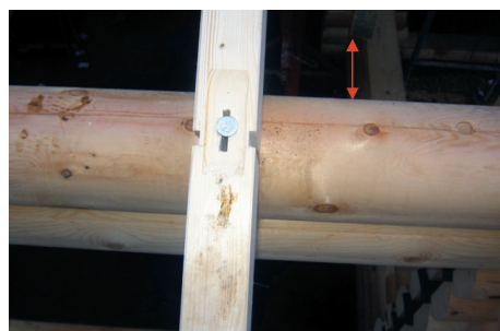
Stand der Technik: Eine Befestigung mit Langloch ist optisch ansprechend. Dies gilt besonders bei sichtbaren Sparren.
