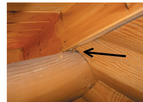
Ohne eine Befestigung ist das Sparrenaufleger zwar gleitend, jedoch nicht zugfest verankert.
