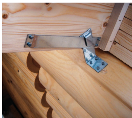
Gleiteisen gehören zu den häufig verwendeten Befestigungen bei gleitenden Sparrenauflegern.
